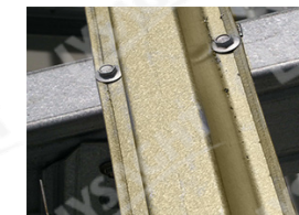
Hình 9.1.6.c Cách bắn vít liên kết thanh TS vào thanh dàn
