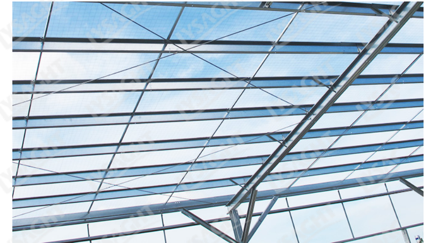
Hình 8.1.5.b Thanh tiết diện Z làm xà gồ
