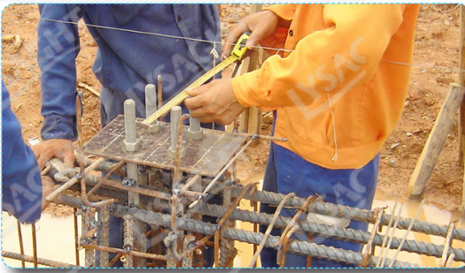
Hình 8.2.4.a Kiểm tra bu lông neo trước khi đổ bê tông
