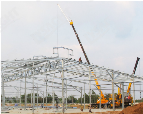
Hình 8.2.2.b Lắp khung bằng cầu
