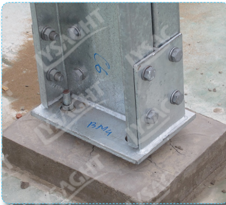
Hình 8.2.4.b Chỉnh cao độ và chờ đổ vữa chèn
