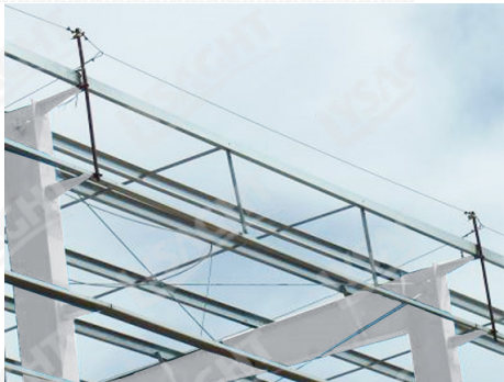
Hình 8.2.2.a Cọc và cáp cứu sinh
