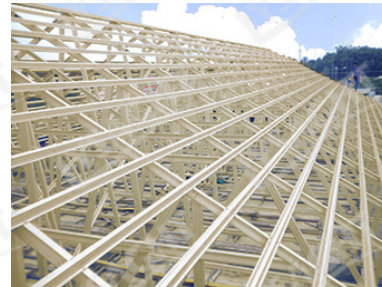
Hình 7.5.2.a Xà gồ mái ngói dùng thanh TS
