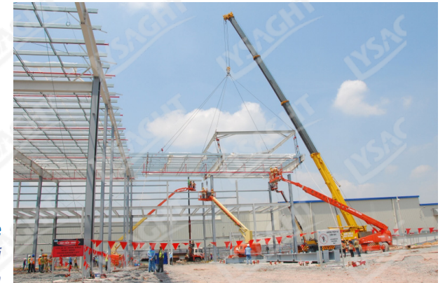
Hình 2.1.3.e Tổ hợp hệ khung, giằng và thiết bị thành từng khối dưới đất rồi cấu lên
