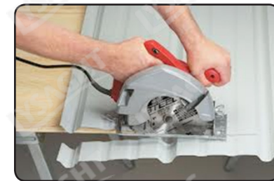
Hình 2.5.1.f Cắt tôn bằng máy cưa đĩa
