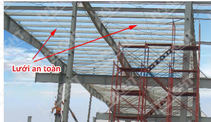
Hình 2.1.2.a Giăng lưới an toàn bên dưới khu vực lợp tôn
