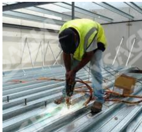
Hình 7.1.3.c Hàn đinh chống cắt (shear stud)
