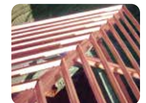
Dầm chéo dầm hồi Rafter diagonal bracing
